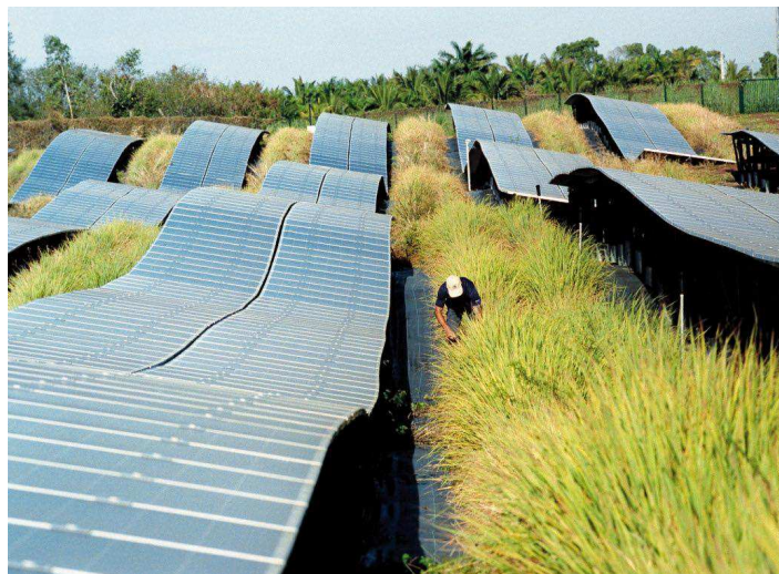
La centrale photovoltaïque de Pierrefonds, sur 3,8 hectares, permet aussi de produire 80 kilos d'huile essentielle de citronnelle par an (photos François Louis Athénas).
